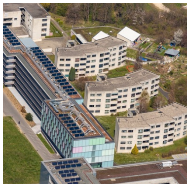
Rénovation immeubles CIPEF, Ecublens
