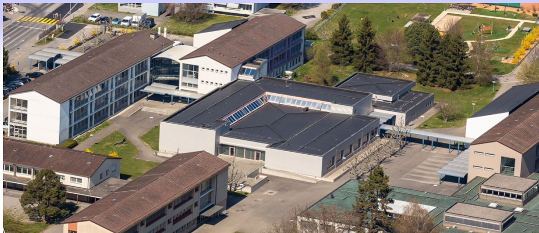
Rénovation du Collège du Pontet à Ecublens (2025)
