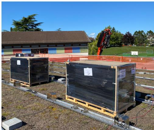
Dans des conditions météorologiques parfaites, notre premier chantier a démarré le 4 septembre avec la pose des échafaudages, suivi par l'implantation des châssis le 14 et la livraison des panneaux le 20.
